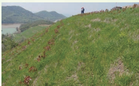
城門山南坡排土場部分終採邊坡
