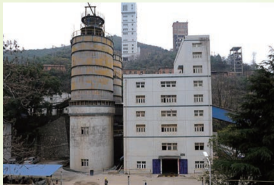
武山銅礦膠結充填站
