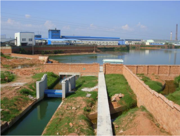
企业总排口（串山垄水库排口）
