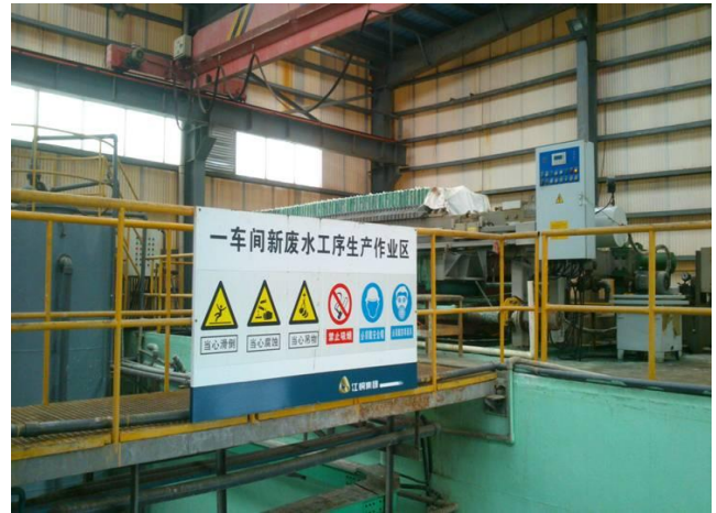
一车间废水处理系统
