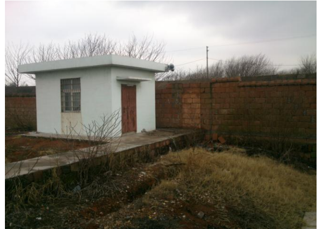
废水总排口在线站房
