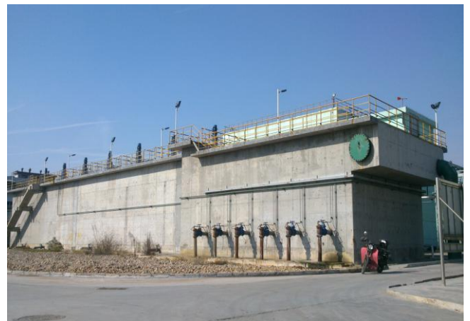
应急水处理站
