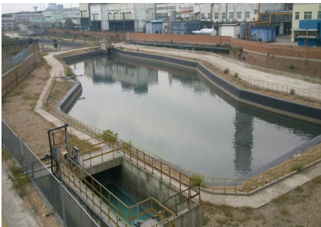
应急处理站收集池
