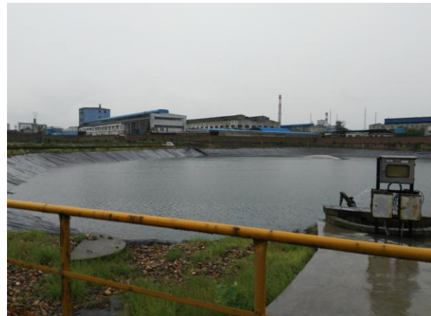
厂区内地下水
