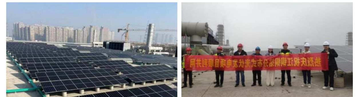
圖：光伏發電專案現場圖
