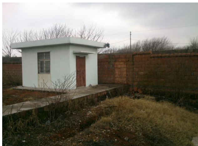
废水总排口在线站房
