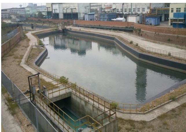
应急处理站收集池
