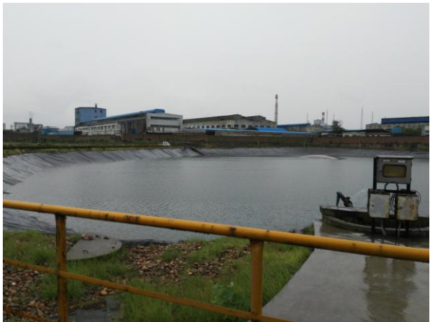
厂区内地下水
