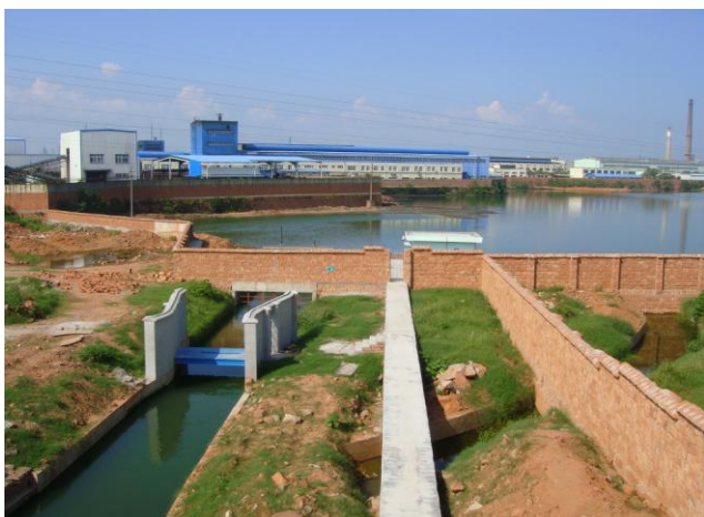
企业总排口（串山垄水库排口）
