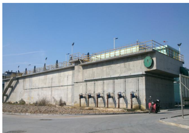
应急水处理站
